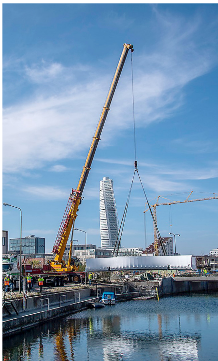
Figur 10: Installation av Neptuni-bron. Det tog en timme att installera den 10-ton bron.
