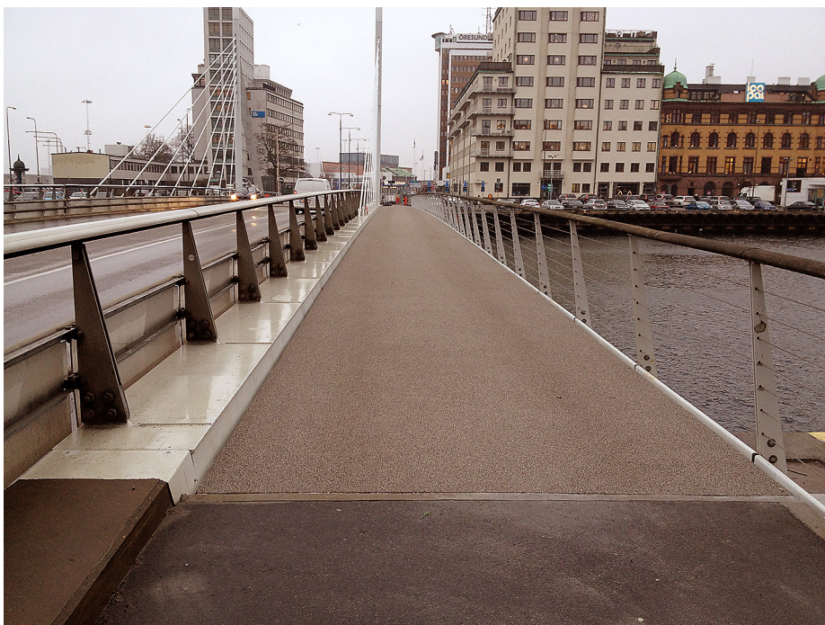
Figur 9: FRP-paneler installerade på gångbana.
